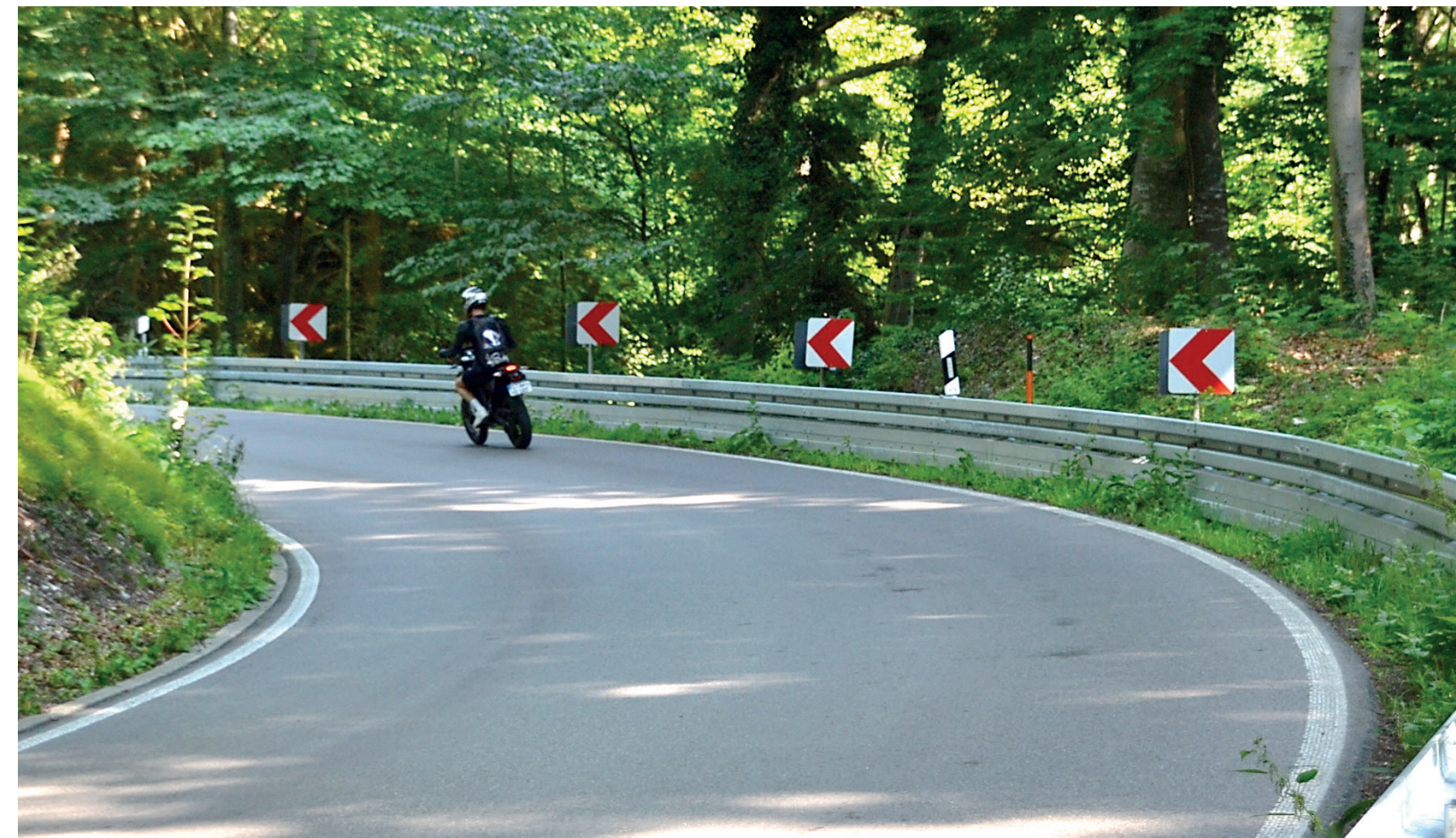
Abb. 27 Beispiel einer schlecht einsehbarer Kurve mit aufgelösten Richtungstafeln, Schutzplanke und Unterfahrschutz
