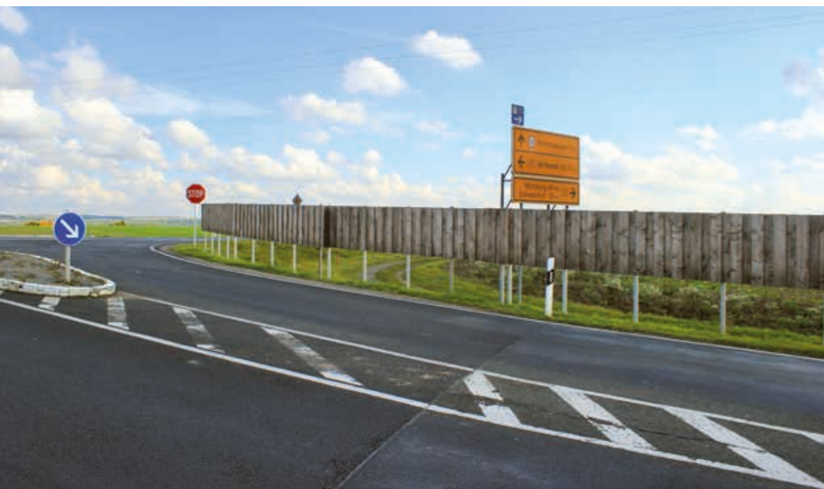
» Abb. 23 „Blickdichte“ Sichteinschränkung in der untergeordneten Zufahrt einer verkehrszeichengeregelten Kreuzung
